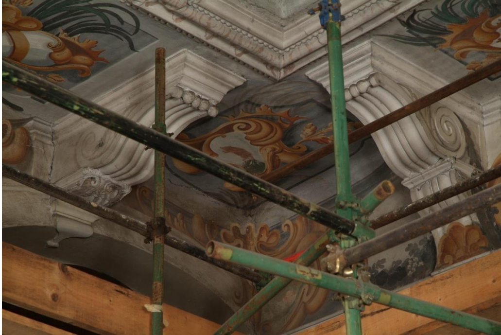
Scalone d'onore prima del restauro
