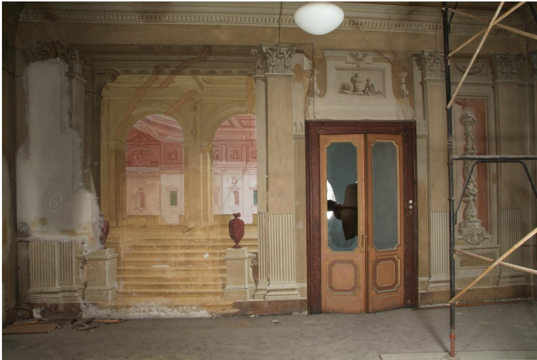
Sala interna prima dell'intervento
