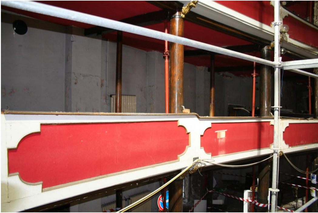
I palchetti prima dell'intervento
