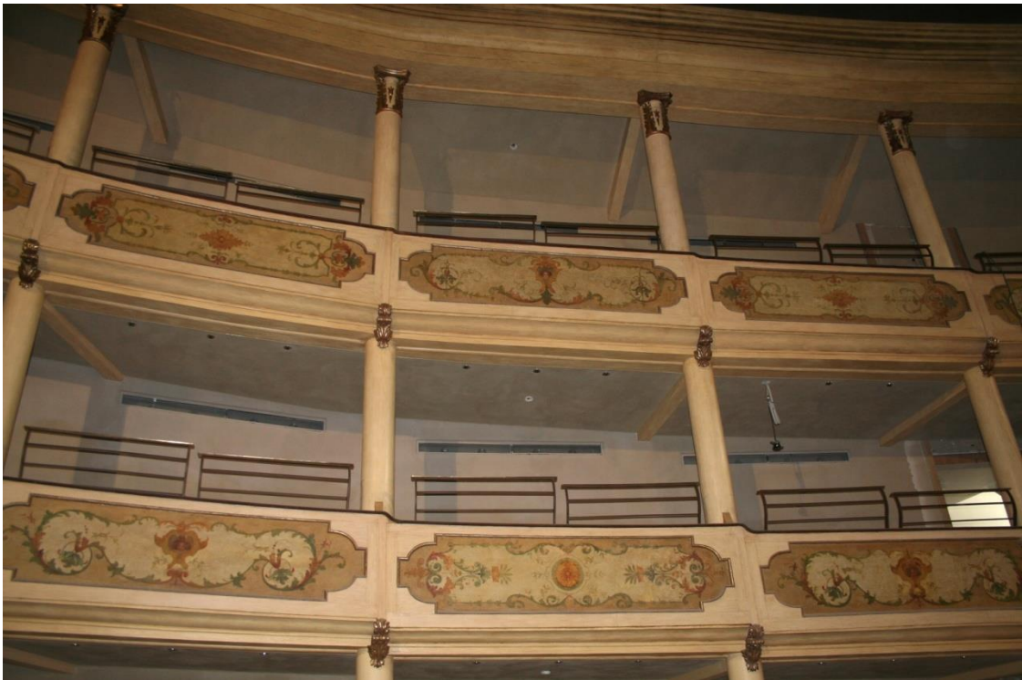
A restauro ultimato
